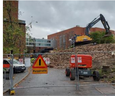
Ny- och ombyggnation
